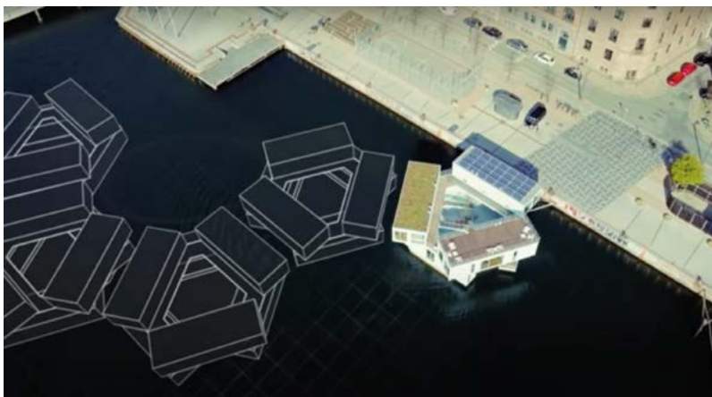
Ilustracja 105. The Urban Rigger. Źródło: Home (2023), Urban Rigger , https://urbanrigger.com/ (dostęp: 29 czerwca 2023).
