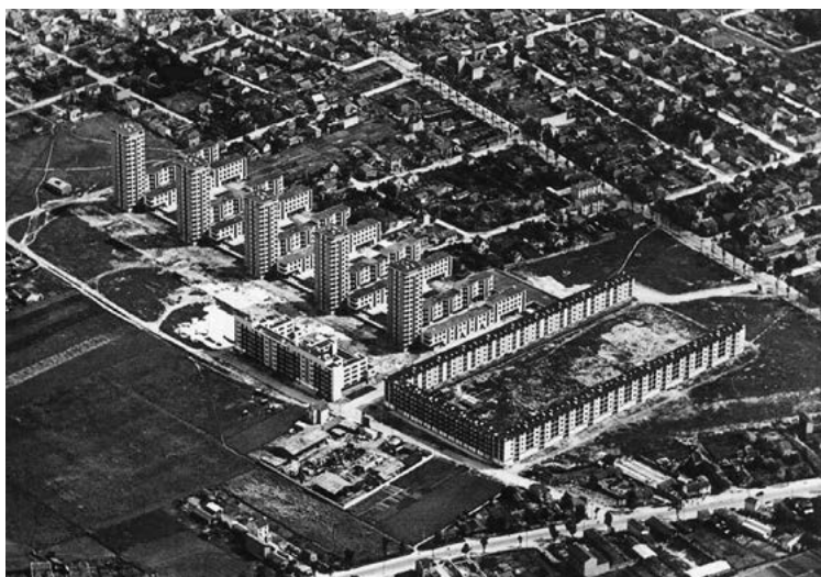
Ilustracja 91. Bloki wybudowane z wielkiej płyty w Drancy w 1934 roku. Źródło: Pont Morland Soundlandscapes' Blog , https://soundlandscapes.wordpress.com/tag/pont-morland/ (dostęp: 29 czerwca 2023).
