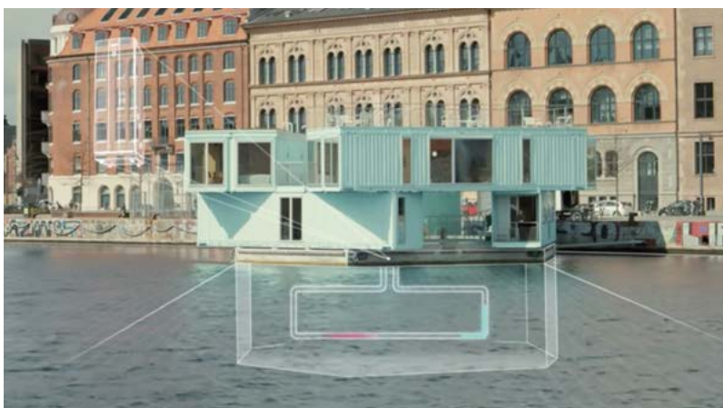
Ilustracja 106. The Urban Rigger. Źródło: Home (2023), Urban Rigger , https://urbanrigger.com/ (dostęp: 29 czerwca 2023).
